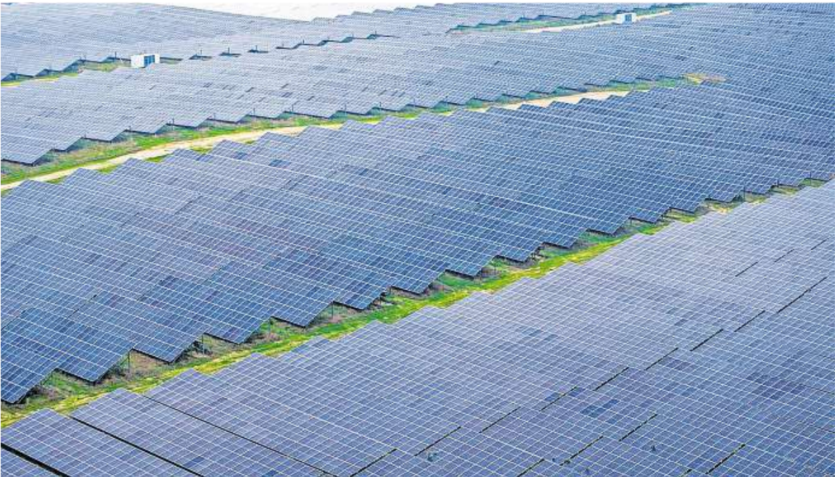
Der Ausbau erneuerbarer Energien – hier die größte Agri-PV-Anlage Deutschlands in Mecklenburg-Vorpommern – schreitet voran. Trotzdem gibt es technischen Nachholungsbedarf.
